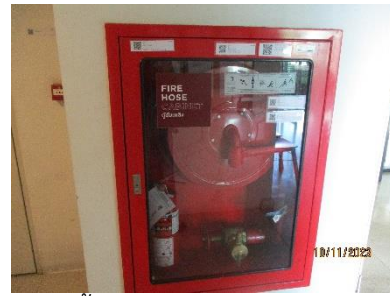
ตู้สายฉีดน้ำดับเพลิง (Fire Hose Cabinet)
