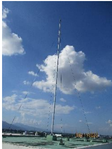
ระบบป้องกันฟ้าผ่า (ระบบป้องกันฟ้าผ่าแบบสายล่อฟ้า)
