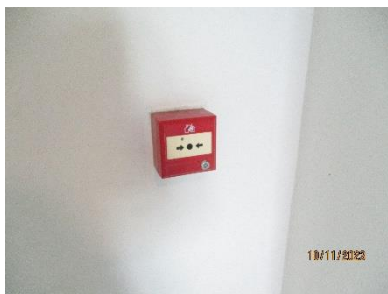
ระบบแจ้งเหตุแบบใช้มือกด (Manual Station)
