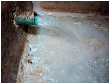
ภาพที่ 2-17 การทำความสะอาดและตรวจสอบถังเก็บน้ำสำรอง
