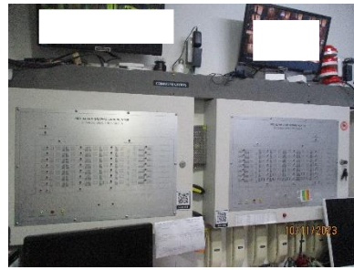
แผงสัญญาณแจ้งเหตุเพลิงไหม้ (Fire Alarm Terminal Box ; FA)
