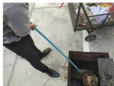
ภาพที่ 2-16 การตัดไขมัน
